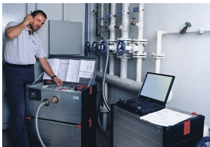
Druckluft einspeisung an Verteiler.
