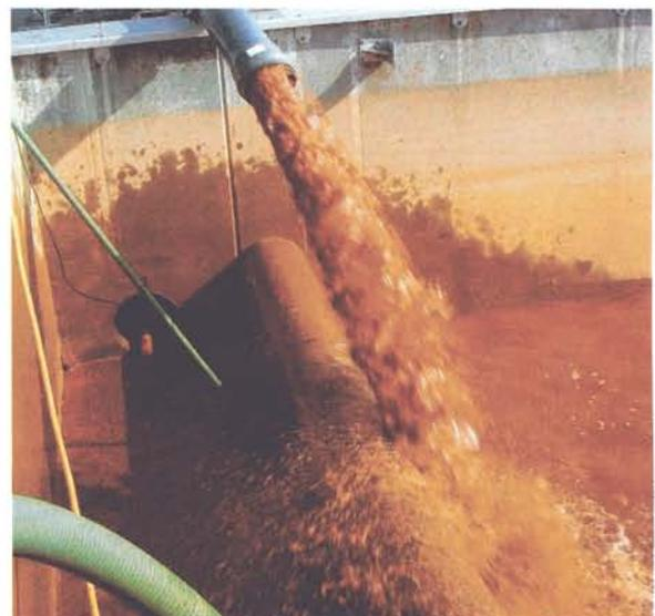
Abb. 11: Austragen von eisenhaltigen Ablagerungen aus Rohwasserleitungen in Cham mittels Complex-Verfahren
