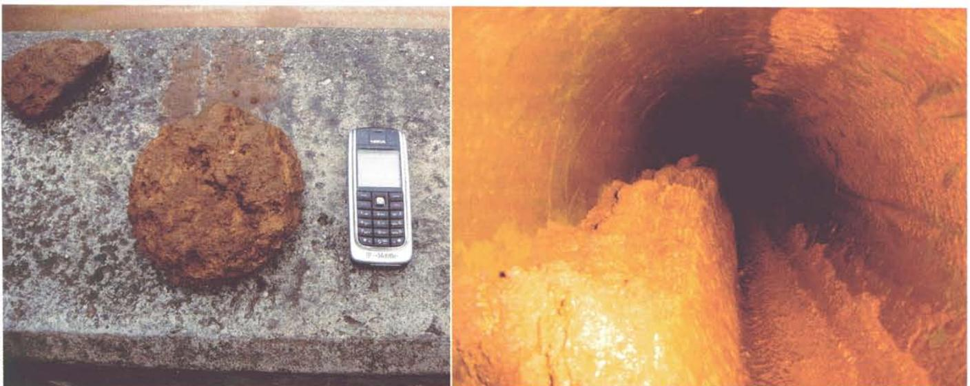
Abb. 12: Impuls-Spülung bei AZ-Rohrleitungen mit harten Ablagerungen: (a) Entfernen von harten Ablagerungen; (b) teilweise versteinerte Ablagerungen
