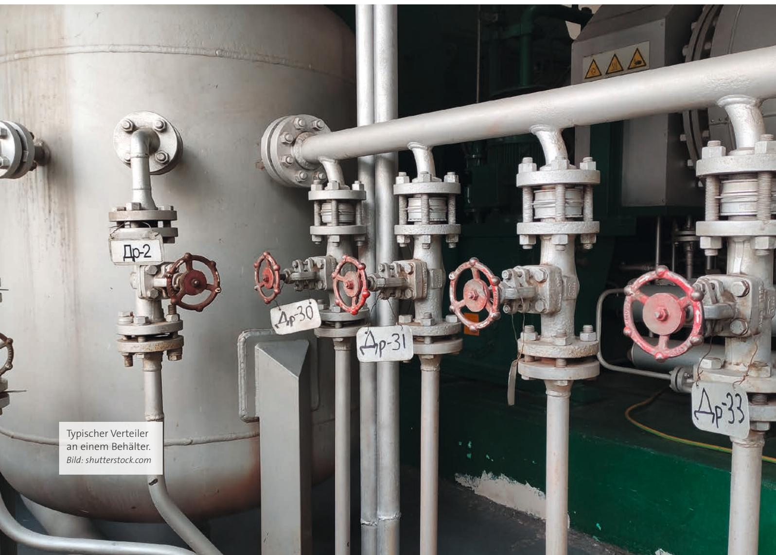
Typischer Verteiler an einem Behälter.
