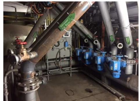
Abbildung 3: Vor- und Rückläufe des Kühlkreislaufes
