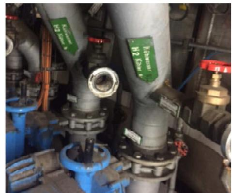
Abbildung 4: Adapteranschluss des Kühlwasservorlaufes
