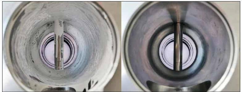
Blick in Anlagenteil für Dispersionsfarben vor und nach der Reinigung.
